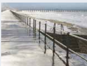
Digue de Luc-Sur-Mer Constructeur métallique : FRAMEIO (Carpiquet - 14)
