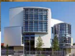
Conservatoire de musique et danse Maurice Ravel de Villemomble Constructeur métallique : Ateliers Mondevilais de Constructions Métalliques (Mondeville - 14)
